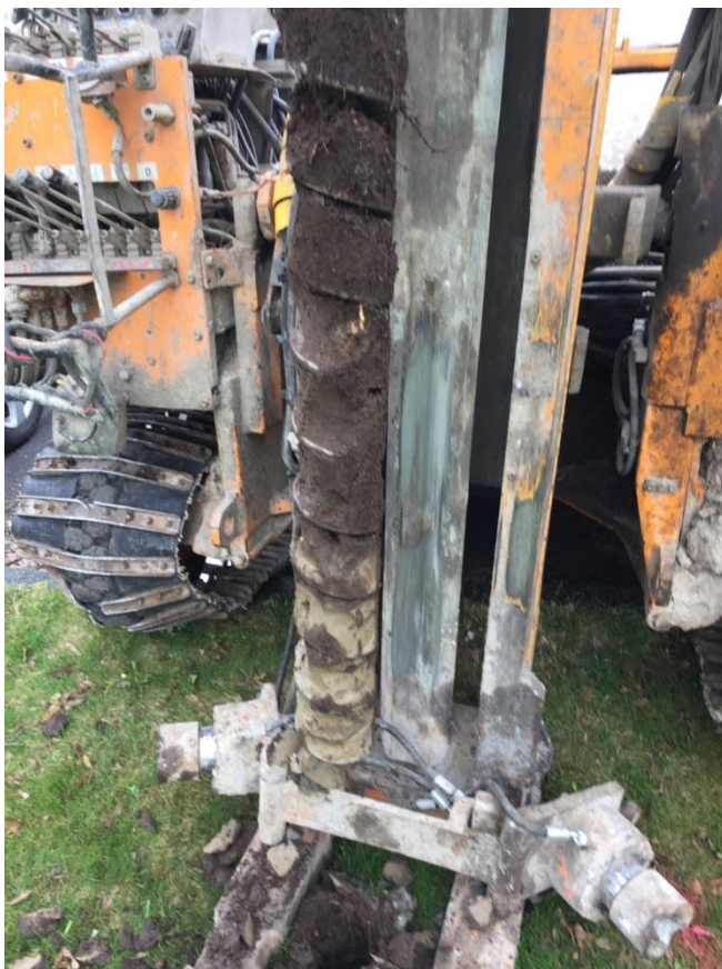
Figur 7. Skruvborrning i punkt R1826, 19 april 2018.
